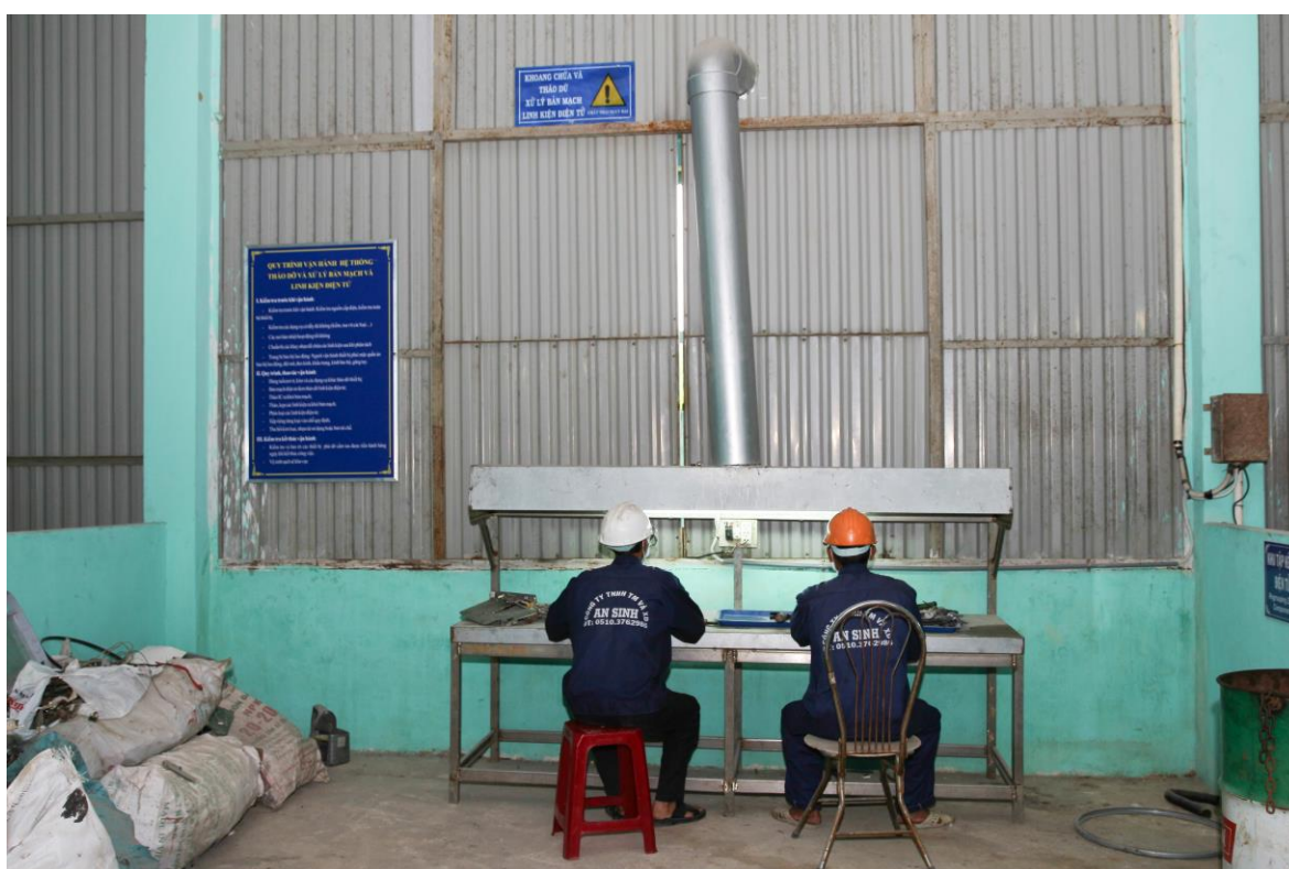
Hệ thống phá dỡ bản mạch điện tử – 500kg/h
